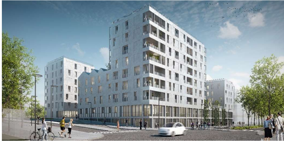
Crédit photo : Berranger|Vincent Architectes (Archange à gauche, Orphéa à droite sur la photo)
